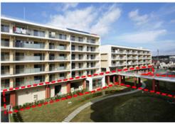
レベル2津波による浸水が想定される敷地における対策として、1階をピロティとし、2階を渡り廊下でつなぐ事例
