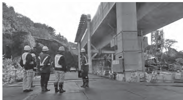
写真 4. 工事現場全景
