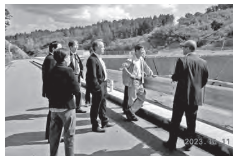
写真5. 鶴岡市一般廃棄物最終処分場
