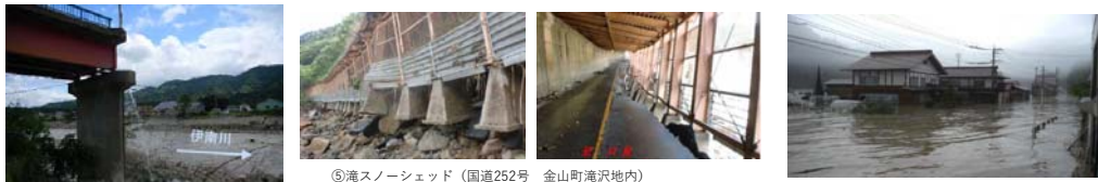
④小川橋（町道福井小川線 只見町小川地内） ⑤滝スノーシェッド（国道252号 金山町滝沢地内） ⑥金山町西谷地内 写真①③④⑤ 出典：平成23年7月新潟・福島豪雨による被害概況（福島県土木部） 出典：平成23年7月新潟・福島豪雨「あいつの今」（福島県会津若松建設事務所）
