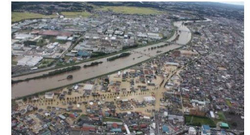
郡山市内水被害（郡山市昭和地内）
