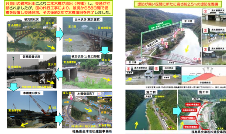
国道252号橋梁災害復旧（二本木橋：金山町横田地内）
