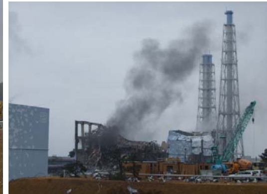
事故後3号機 東電ホールディング 2011.3.21
