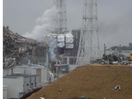
事故後の1～4号機 東電ホールディングス 2011.3.16
