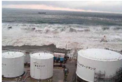
津波襲来の状況 東電ホールディング 2011.3.11
