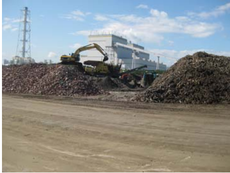
相馬市・新地町 仮置場におけるがれきの分別処理
