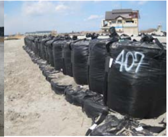
浪江町 中浜海岸大型土のう仮締切
