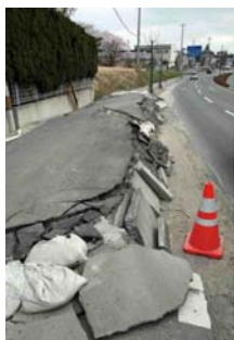
南上町地内（東部環状線）
