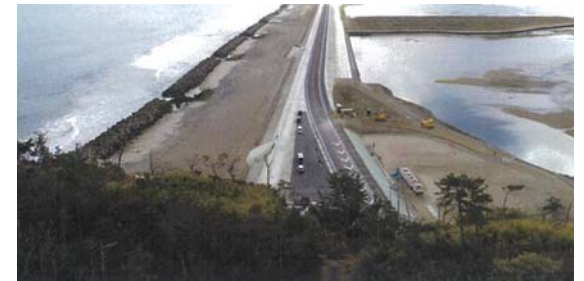
相馬市 大洲地区海岸堤防復旧完了
