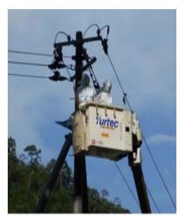
制限区域の作業状況
