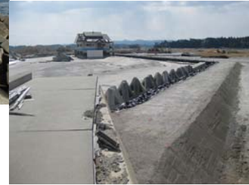
浪江町 中浜海岸大型土のう仮締切
