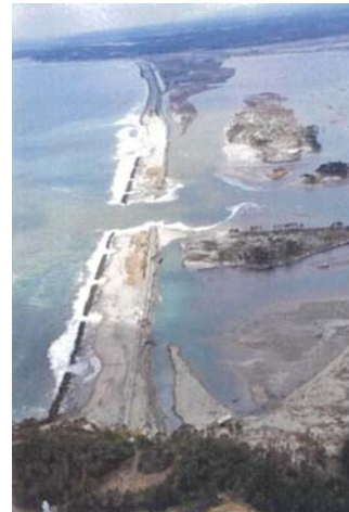
相馬市 大洲地区海岸堤防被災状況
