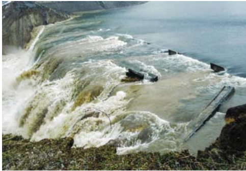
地震→堤体すべり→越流→堤体浸食→決壊
