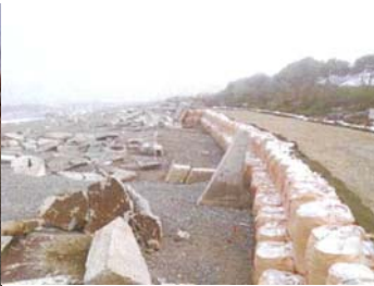
広野町 浅見川海岸大型土のう仮締切
