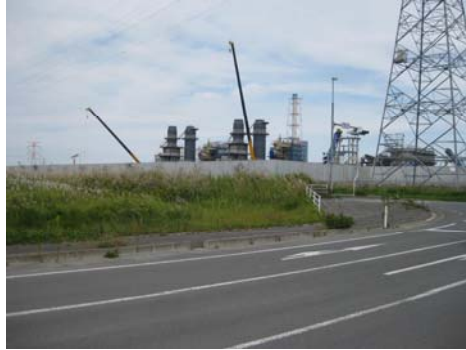
相馬市・新地町 仮設焼却炉の建設
