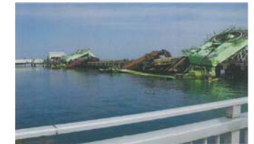
揚炭機被災状況
