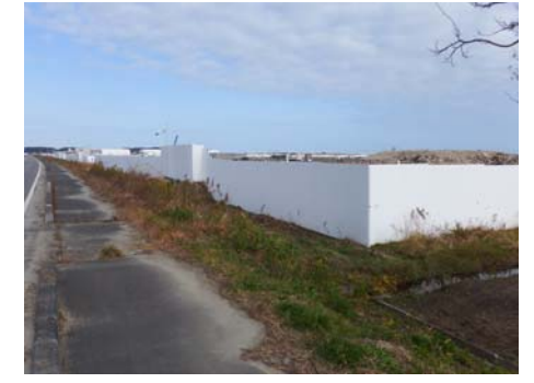
浪江町請戸地区 震災がれき仮置場
