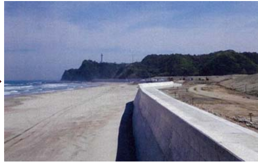
いわき市 豊間漁港海岸堤防復旧完了
