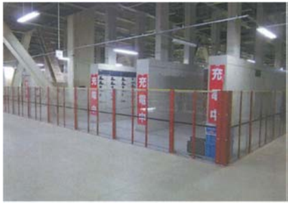
電源設備周り防水壁設置状況
