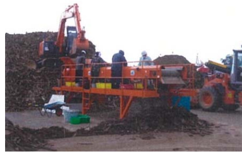
いわき市 震災がれきの分別作業
