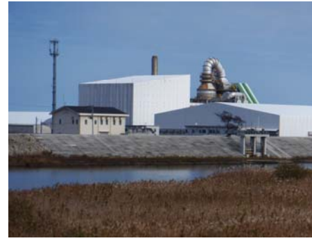
浪江町棚塩地区 仮設焼却炉
