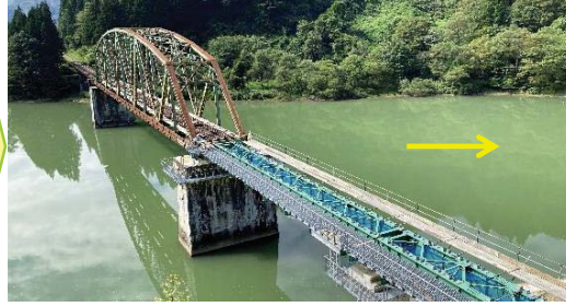
復旧状況 2020.9.17撮影
