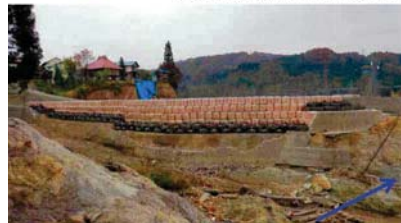
【応急工事実施状況】 大型土のう(H23.10下旬完了)
