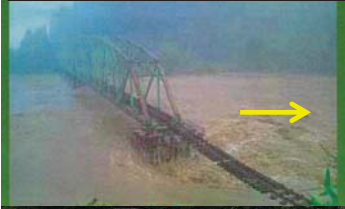
出水時の状況 (福島県土木部提供)
