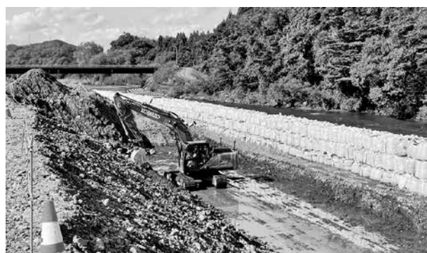
写真 3. 松川の河川改修（ICT 建機による掘削）
