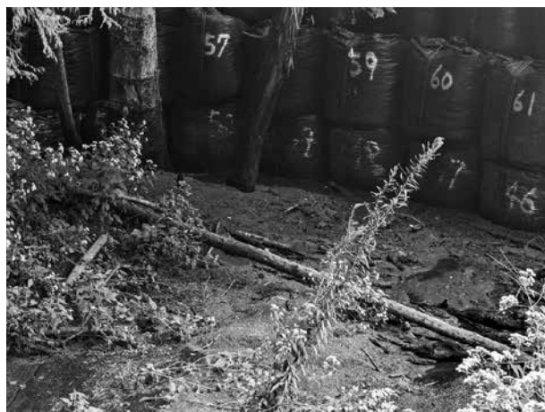
写真 5. 土砂を止めた緊急対策
