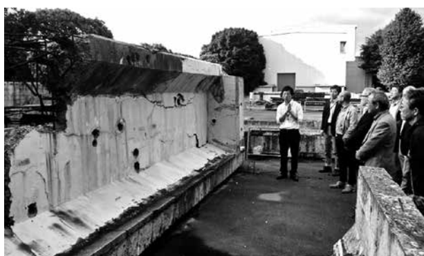
写真4. 山形県鶴岡市暮坪陸橋のPC桁
