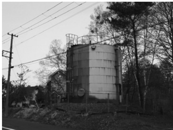
写真2. 別荘地内に立つ貯湯槽
