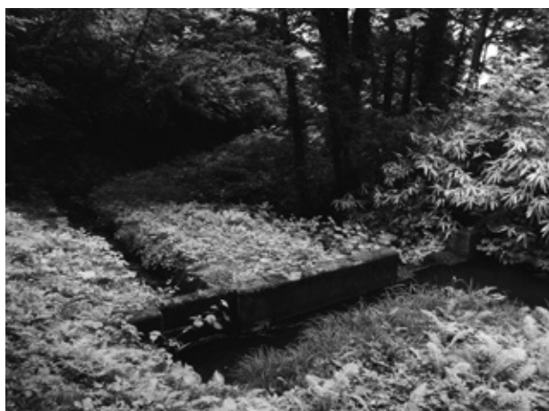
写真5. 地元集落の農業・生活用水施設
