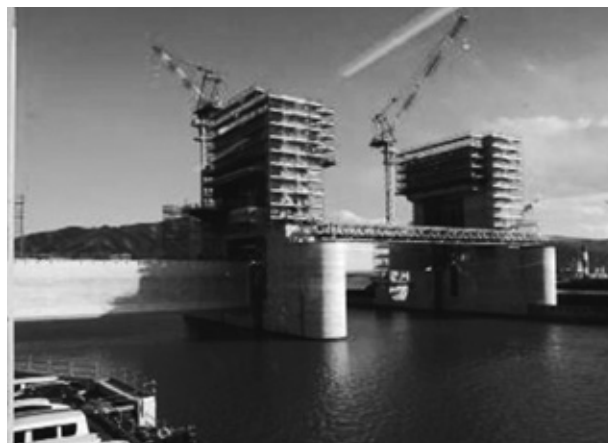
写真4. 閉伊川水門工事状況
