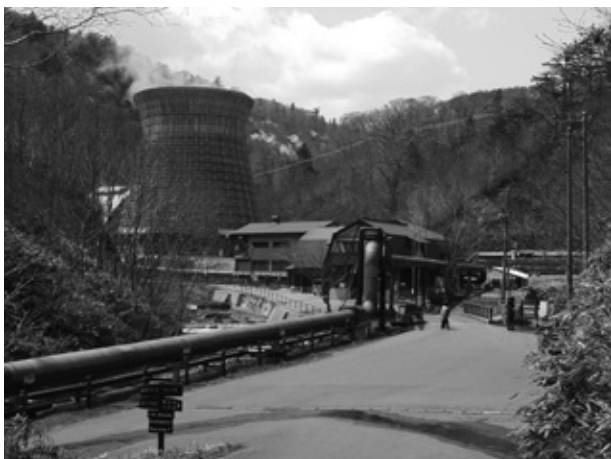
写真1. 松川地熱発電所
