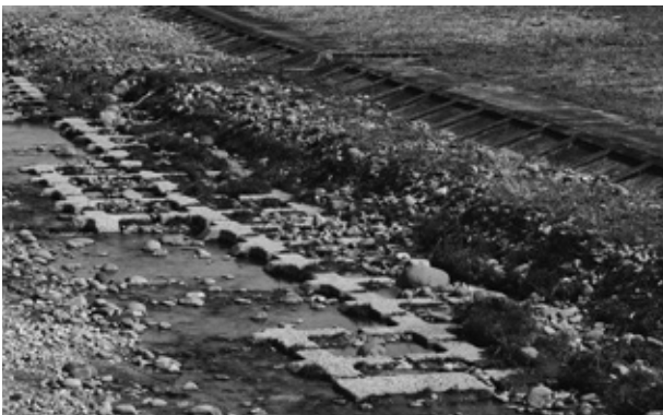
写真1. 最上川の法枠と十字ブロック
