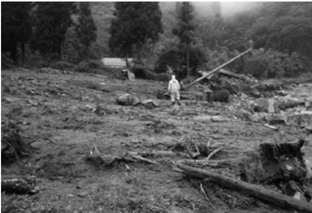
写真4. 内川筆甫中流部左岸土石流による河岸崩壊
