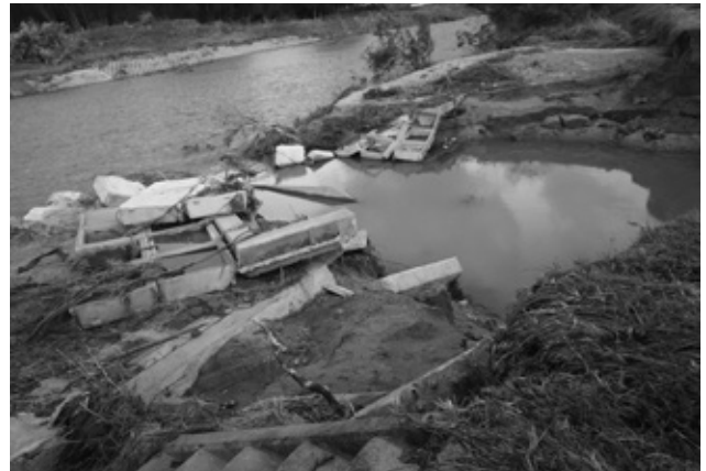
写真7. 内川下流右岸堤防決壊
