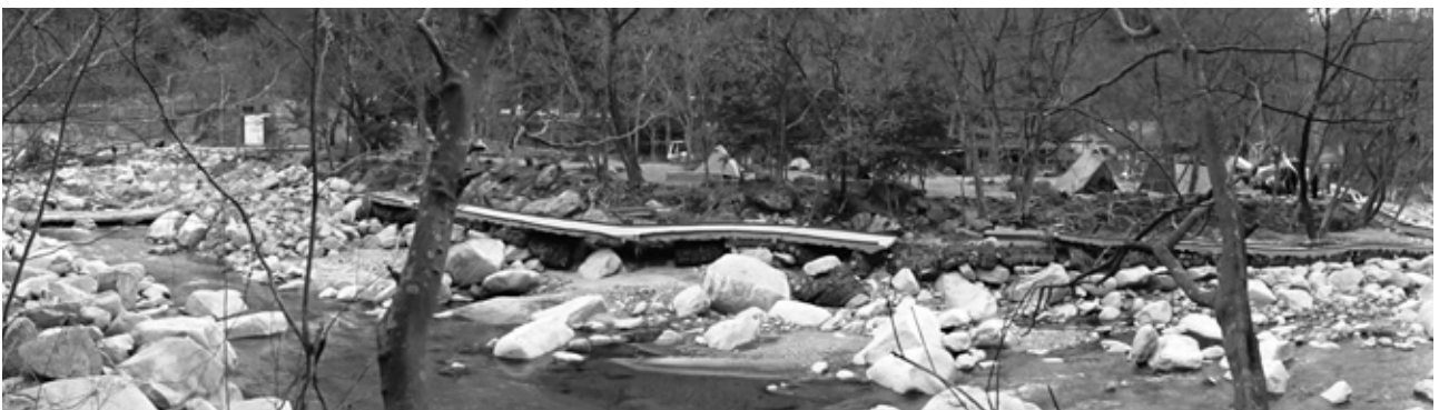
写真5. 内川不動地区不動公園部右岸河岸の崩壊
