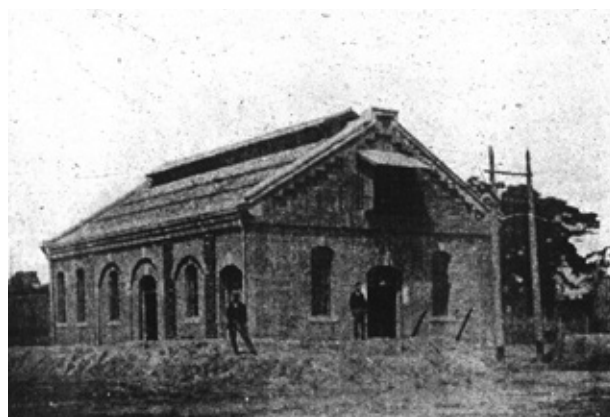
写真3. 赤いレンガ造りの変電所（1899年頃撮影）
