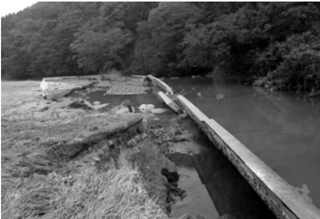
写真3. 内川筆甫中流部左岸護岸の崩壊
