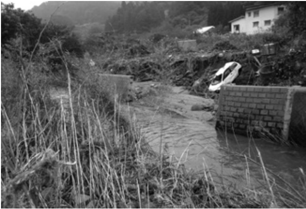
写真2. 筆甫上流地区右岸河岸の崩壊
