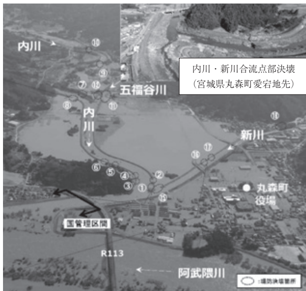
写真1. 内川及び支流の破堤箇所(国交省ホームページ抜粋)
