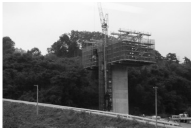
写真2. 国道115号 復興支援道路工事状況
