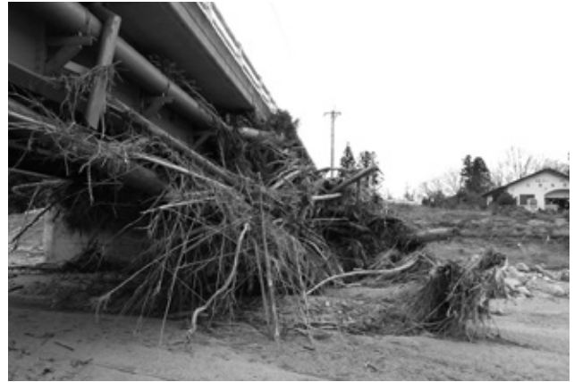
写真6. 内川下流橋梁流木の捕捉状況
