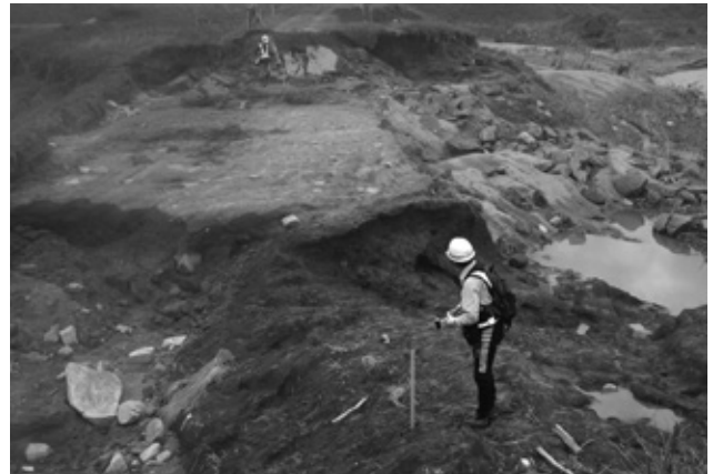
写真8. 内川下流部左岸堤防決壊
