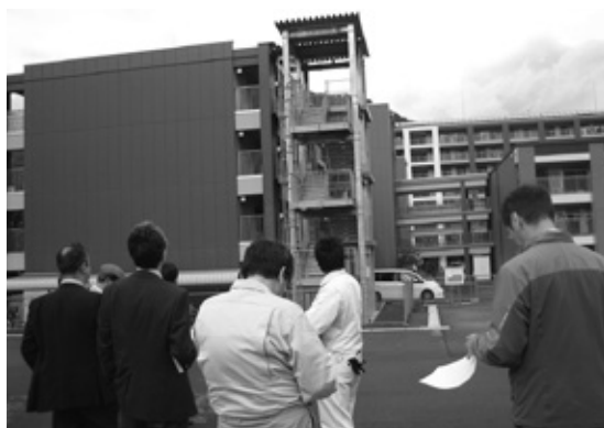
写真4. 上中島町復興公営住宅Ⅱ期
