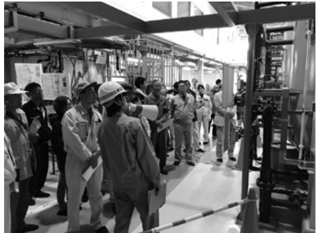
写真5. 浸出水処理施設内見学の様子
