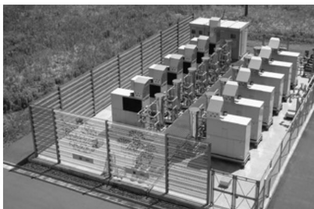
写真1. 消化ガス発電機
