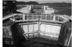
写真3. 石井閘門・水門
