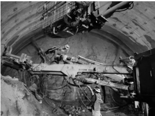
写真6. 液体急結剤使用による吹付状況
