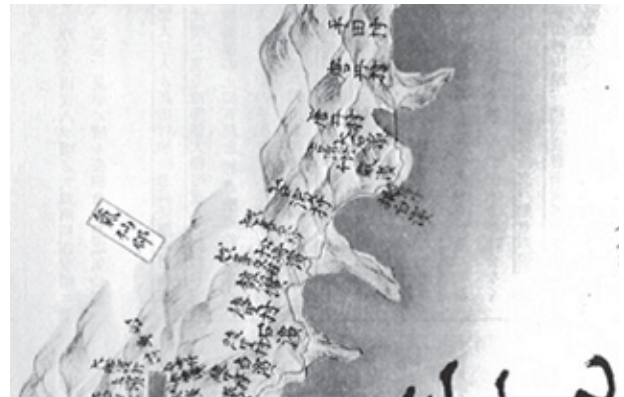
図 1. 測量の様子（資料より）
