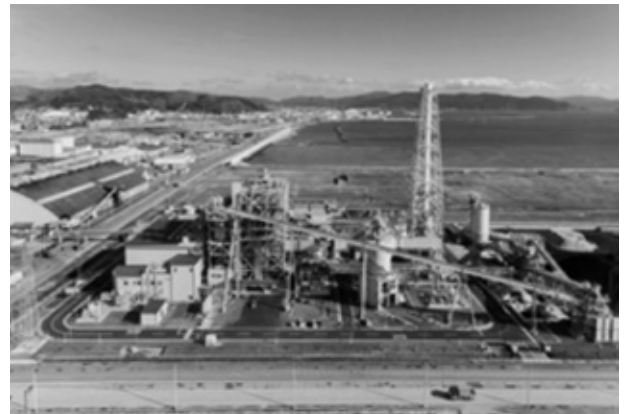
写真5. 石巻雲雀野発電所の全景
