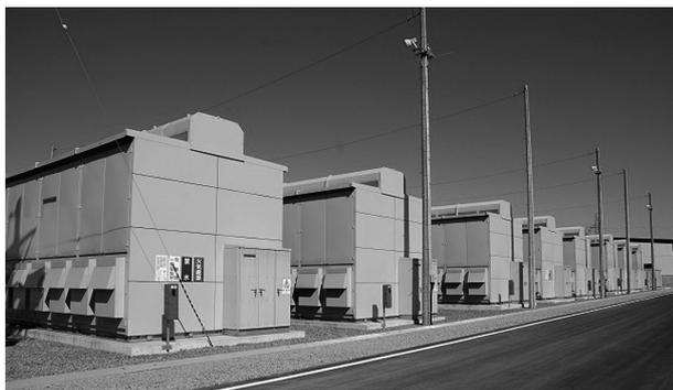
図 4. 蓄電池 (NAS電池) の設置状況
