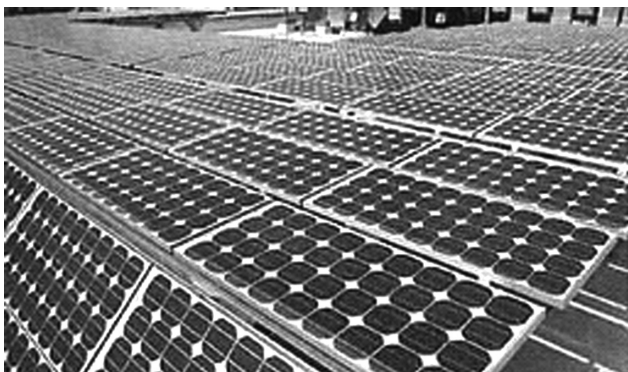
図-3 低層棟塔屋太陽光アレイ設置状況
