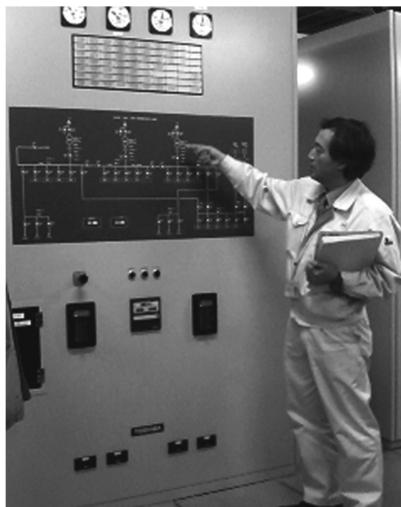
地下受電設備 説明風景
