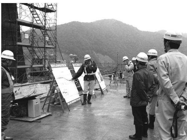
洪水吐コンクリート打設現場での見学
