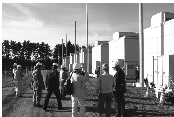
図 7 NaS電池(2,000kw級)×17基 据付状況
